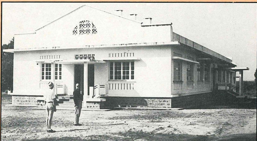
Le premier laboratoire (dit de chimie) est terminé.
