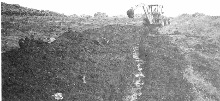
Photo 5 - Creusement d'un drain d'assainissement avec une pelle mécanique.
