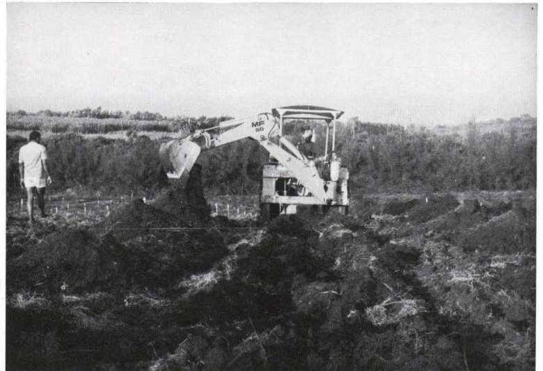
Photo 10. Détail de la même opération.
