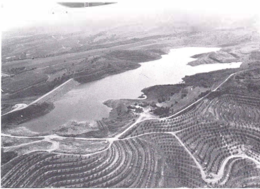
Photo 1. Réserve basse de Peri (équipement hydraulique SOMIVAC) 3 millions de m 3 - Vergers de clémentiniers et d'oliviers en courbes de niveau. Irrigation par goutte à goutte. (Photo A. Carlotti).
