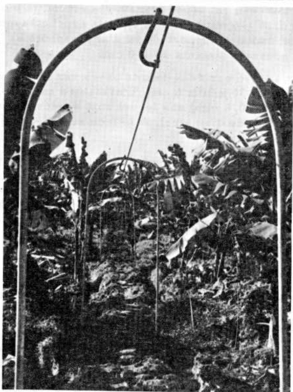
Photo 1 - Rail dressé dans l'évidement central d'une dalle de béton armé.
