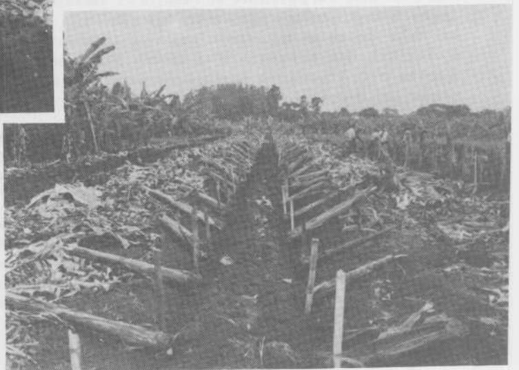
Photo 9 - Le piquetage est terminé et le matériel de plantation mis en place.
