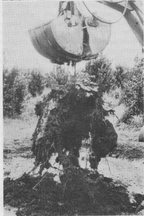
PHOTOS 2, 3 et 4. — Arrachage des racines : différentes étapes.
