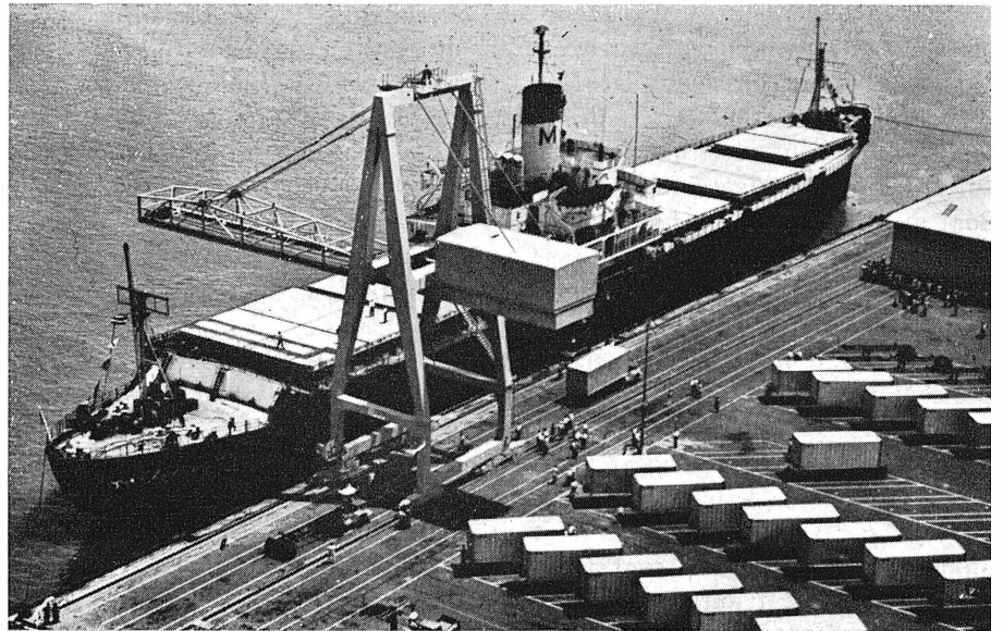
PHOTO 5. — Portique de déchargement des containers. Parc de stockage des containers.
