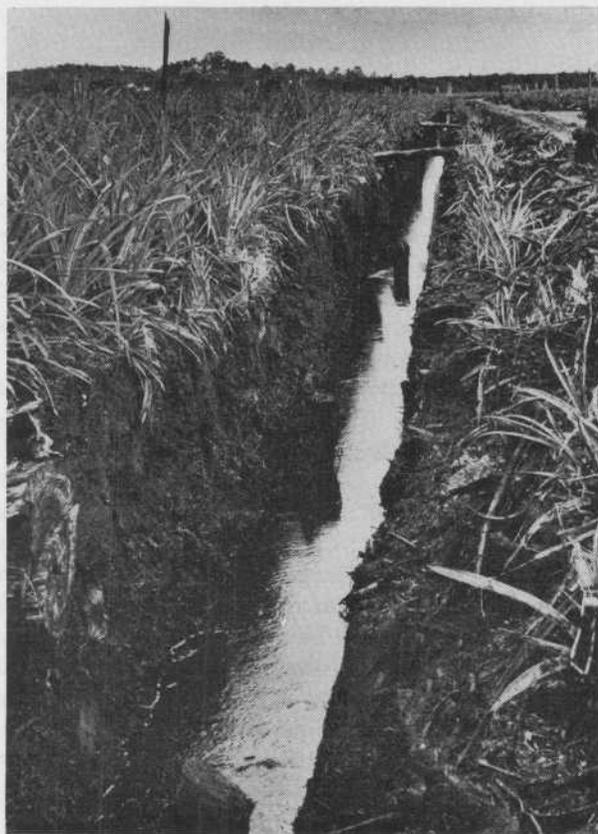
PHOTO 31. — Détail d'un drain. Il est nécessaire de les recréuser régulièrement pour maintenir le niveau de la nappe phréatique à 60 cm de la surface du sol.
