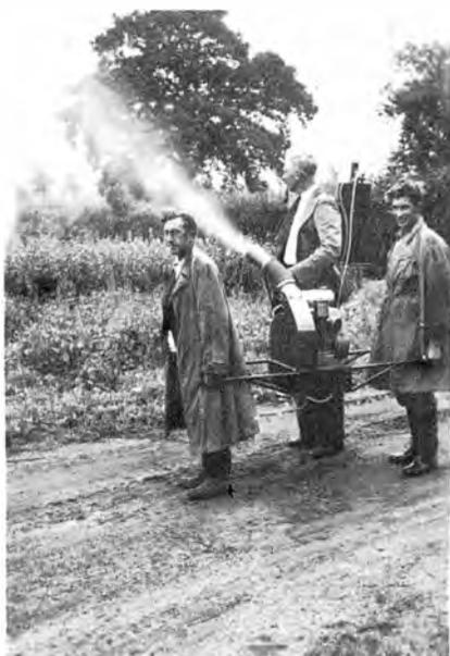
PHOTO 2. — Atomiseur portable pour les applications par « brouillard léger ». (Photo I.F.A.C.)
