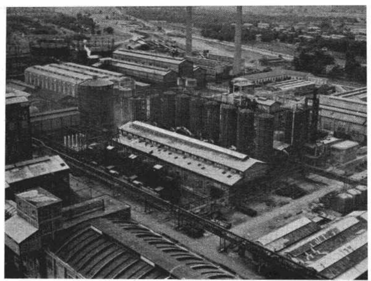
PHOTO 1. — Vue générale aérienne des installations de l'Office National Industriel de l'Azote (O. N. I. A.) à Toulouse. (Cliché S. P. I. E. A.)
