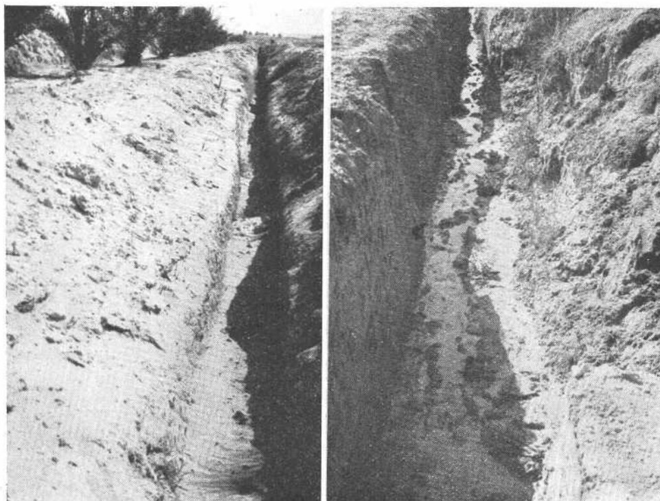
PHOTO 6. — Après le vent de sable
