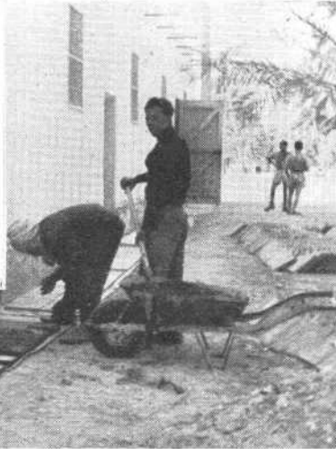
PHOTO 3. → Aménagement d'un drain en- terré : saignée, cailloutis, dal- les, comblement (Photo Wertheimer).
