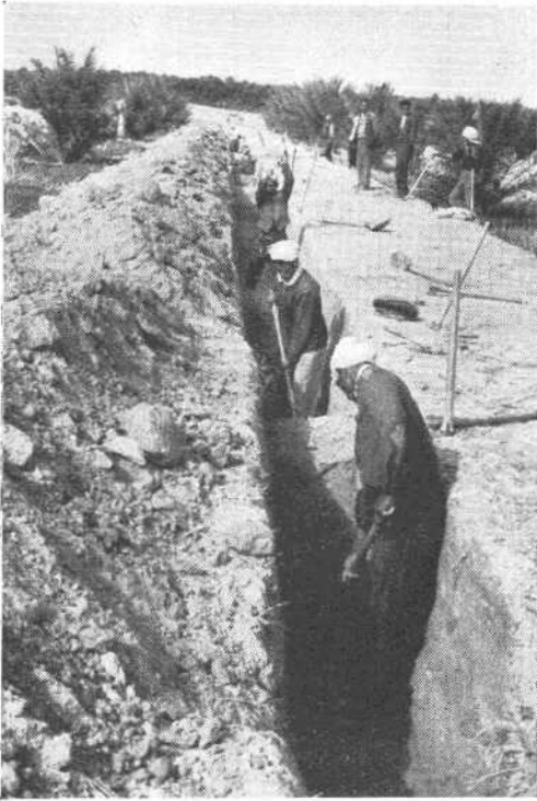
← PHOTO 1. Creusement d'un drain (Photo Wertheimer).
