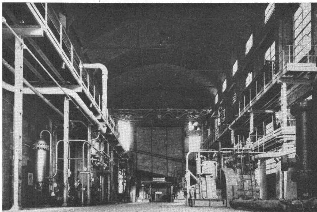
Fig. 3. — Une étape de fabrication de l'Azote organique de synthèse. Synthèse de l'Urée à l'Office National Industriel de l'Azote. Toulouse.
