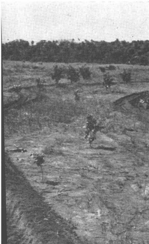
FIG. 4. Vue rapprochée d'un fossé anti-érosion après finition par la main-d'œuvre (Photo Tisseau).
