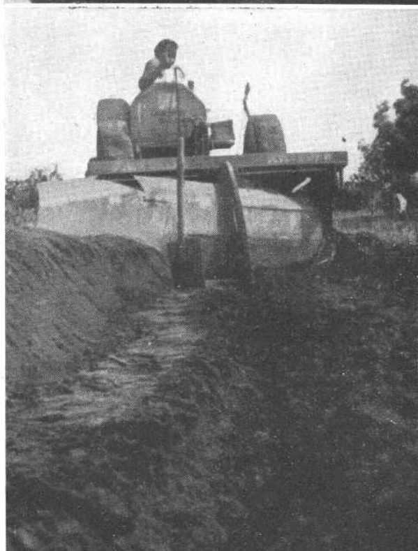
FIG. 3. — Détail du travail de la lame profilée montée sur un châssis KILLEFER et tiré par tracteur CATERPILLAR D 4. La bêche sert d'échelle (Photos Tisseau).
