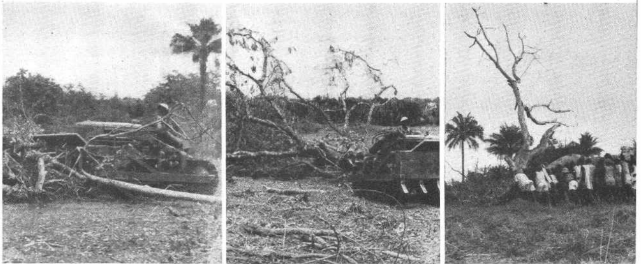
PHOTO 7. — Débardage des abattis à l'aide de la pelle du tracteur International TD 14.
