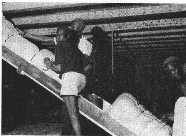
FIG. 23. — Glissière installée dans une cale de navire-bananiier
