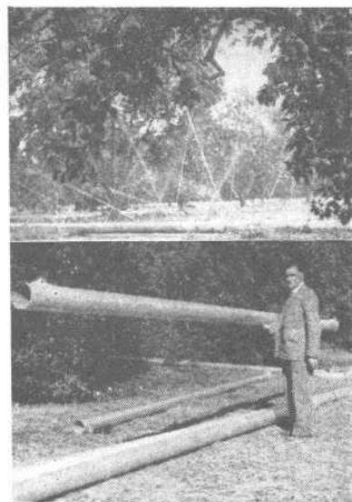
Fig. 13 (en bas). — Arrosage par tuyaux percés tel qu'il se pratique dans les orangeries de Floride.
