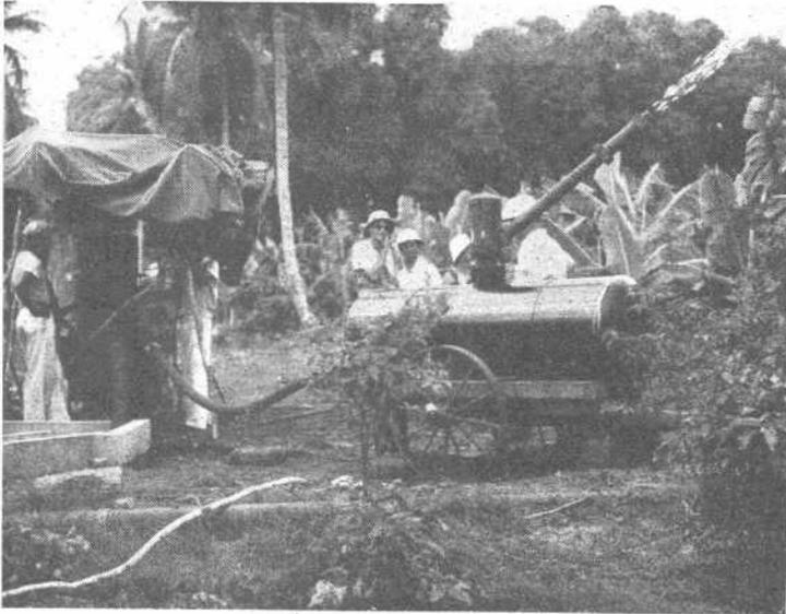
Fig. 2. — Canon d'arrosage intermittent comportant un réservoir de 400 litres en action dans une bananeraie de la Guadeloupe. (Photo M. I. M.)
