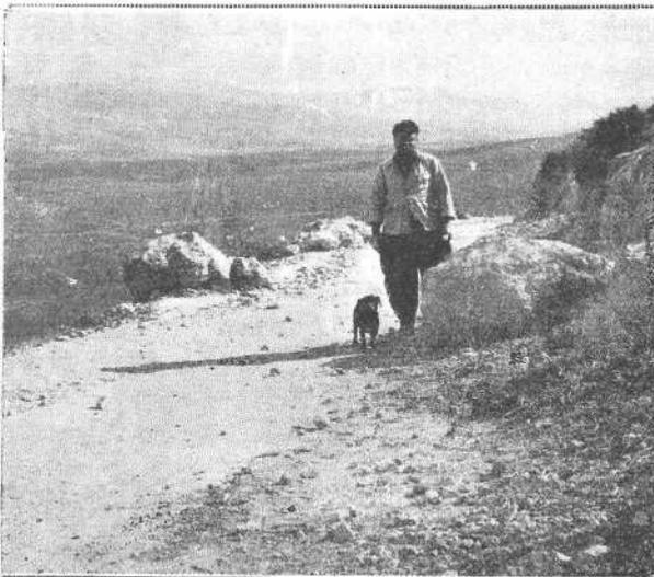
Fig. 15. — Comment on débarrasse rapidement un chemin d'une roche éboulée. La charge est placée par dessous (Gracieusement communiqué par les Etablissements John Kinsmen, Seyssel).
