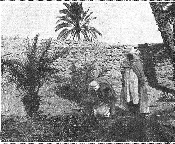
Fig. 14. — Trou de soussolage dans une palmeraie de [Ouargla. Le cheik Salah ben Brahim enfonce sa canne tout entière dans le sol remué par l'explosif, à 2 mètres de l'axe du trou (Gracieusement communiqué par les Etablissements John Kinsmen, Seyssel).
