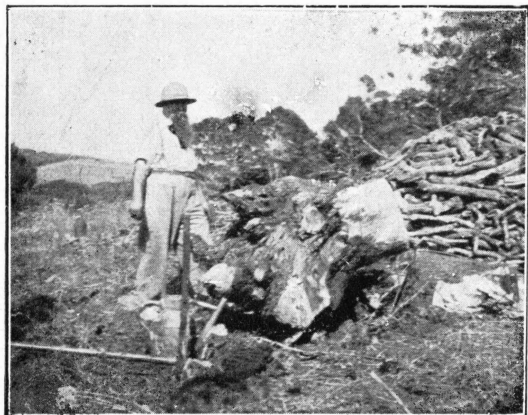
Fig. 1. — Comment on débite une grosse souche : les mines sont placées dans les angles des racines, sous calottes de terre humide tassée, elles partent toute à la fois au tir électrique. (Gracieusement communiqué par les Établ ts John KINSMEN-SEYSSSEL).
