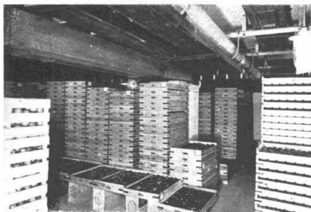
Fig. 2. — Entrepôt frigorifique pour la conservation des fruits. Noter le gerbage des caisses ménageant les passages de séparation des lots et de circulation d'air ainsi que les gaines de ventilation au plafond. (Photo Sulzer).
