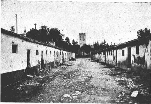
Fig. 1. — MISSERGHIN. Domaine des Pères du Saint-Esprit. Anciennes écuries du temps de la Colonisation. (Photo Comelli, Janvier 1946)
