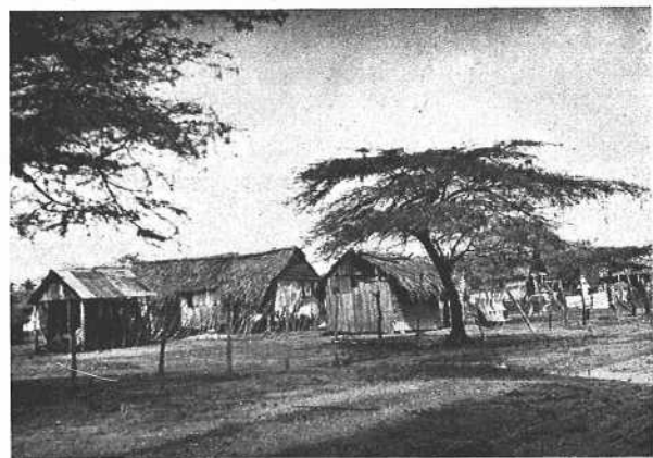
Fig. 7. — Habitations d'ouvriers agricoles à Naggo's head (« tête de nègre ») dans le district bananier près de Spanish Town,
