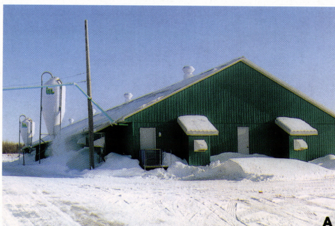
Photos 1A et 1B. Les polluants et les nuisances s'échappent des bâtiments d'élevage dans l'air de ventilation.
