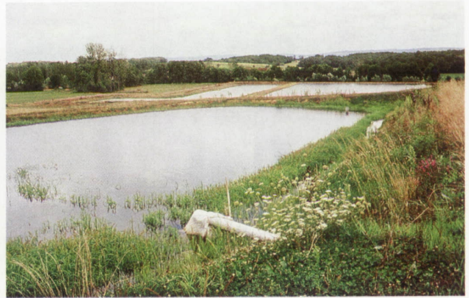
Photo 17. Vue d'une pisciculture d'étang polyvalente (5 à 6 espèces) nouvellement construite en Bresse par P. Dannancier (France). Elle est basée sur la récupération intégrale de l'eau de pluie, le pompage d'eau dans la nappe phréatique à - 30 m et la réutilisation de l'eau de vidange des étangs après transit et épuration dans le bassin récepteur situé à l'aval.
