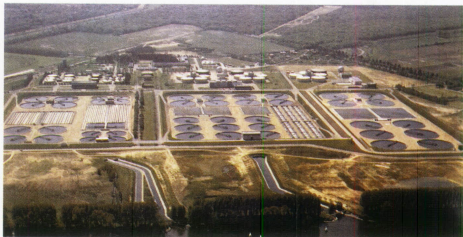
Photo 1. Vue aérienne de la station d'Achères.
