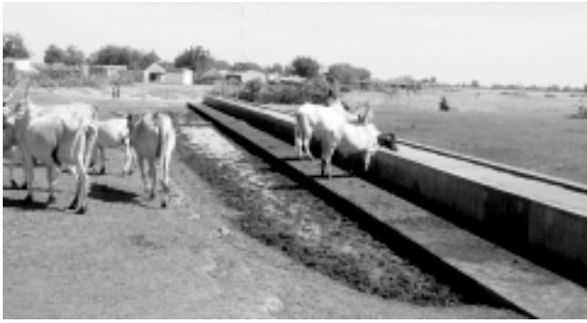
Figure 8 : un abreuvoir au niveau de Ranérou (du fait de la fréquentation par le cheptel, les abords sont surcreusés).
