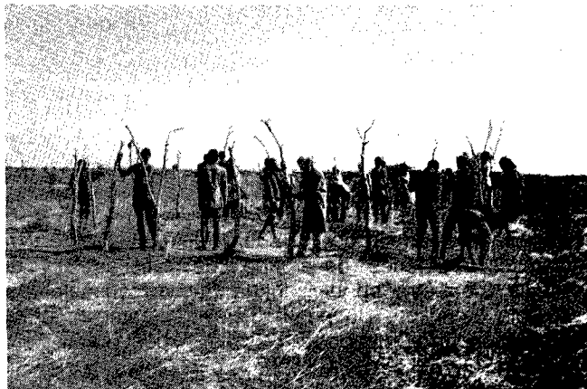
Photo 3 : Pose des piquets de soutien du grillage.
