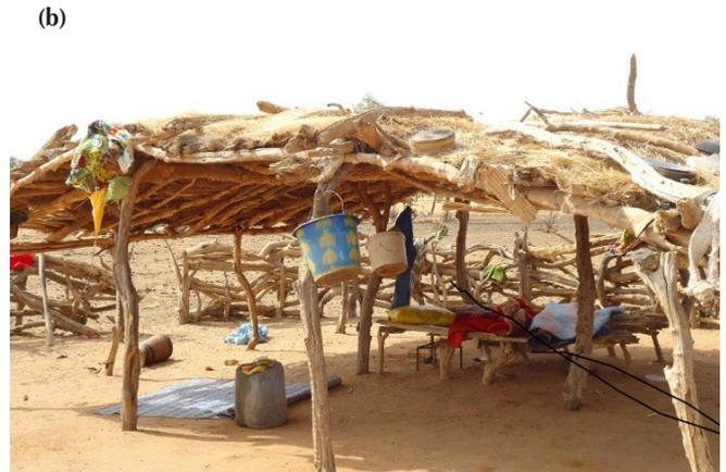
**Figure 2** : branches de *Calotropis procera* en séchage pour construction (a) et ombrière (b) construite avec des pieds d'arbres morts et des branches de *Calotropis procera* (Bakhoum, janvier 2010).
