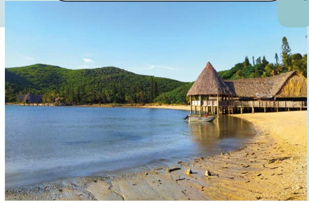
Photo 1. Ponton abrité, réalisé avec des poteaux en pin radiata ( Pinus insignis ) traités au CCA ( Chromated Copper Arsenate ), à Nouméa, Nouvelle Calédonie, France. Photo K. Candelier.
