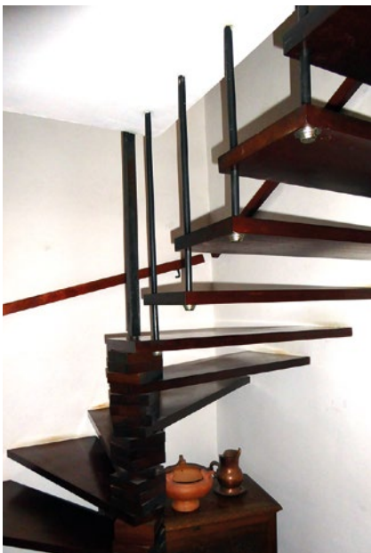
Escalier suspendu demi-tournant, Argelès-sur-Mer (France).
