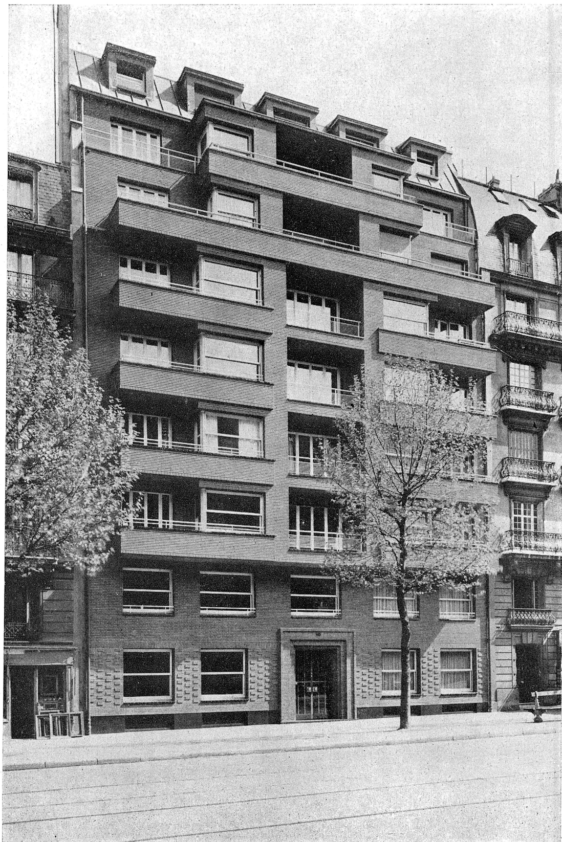
Immeuble 143, boulevard du Montparnasse, à Paris, dont les menuiseries sont en Niangon Architecte : Léon-Joseph MADELINE ; Menuiseries : DIREZ
