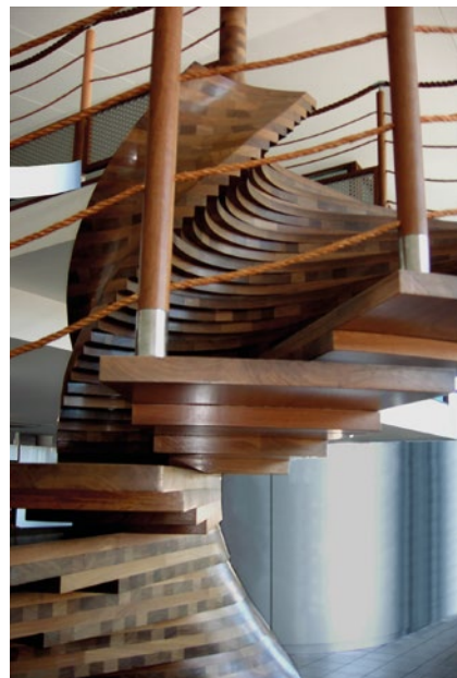
Escalier intérieur en lamellé-collé – Réalisation Les Bois du Pacifique, Nouméa (Nouvelle-Calédonie). Photo J. Gérard, D. Guibal, Cirad.
