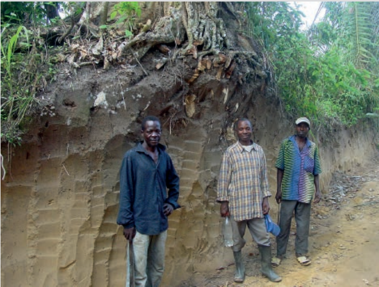
Photo 5. Creusement de la piste, deux mètres en dessous des champs, qui illustre l'érosion hydrique. Photo V. Freycon.
