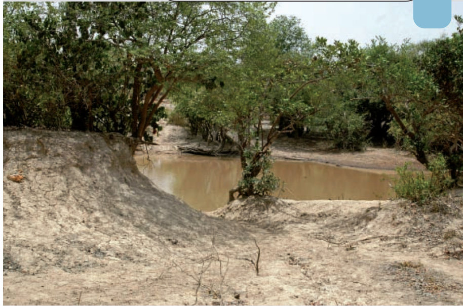
Photo 19. Dégradation et érosion des berges par le piétinement le long de la Koba, à Doundouso. Photo L. Granjon.
