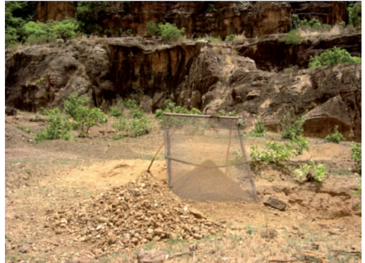
Photo 12. L'extraction du sable et du gravier sur le piémont de la falaise. Photo M. Akoudjin.
