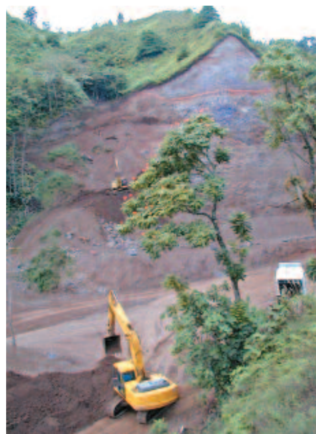
Travaux de terrassement et de déforestation sur les hauteurs de Tahiti, au Pic Vert. Photo J.-Y. Meyer.
