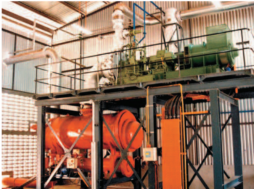
Turbine à vapeur de 900 kW dans une centrale de cogénération à bois, en Malaisie. A 900 kW steam turbine in a wood-fired cogeneration plant in Malaysia. Photo P. Girard.
