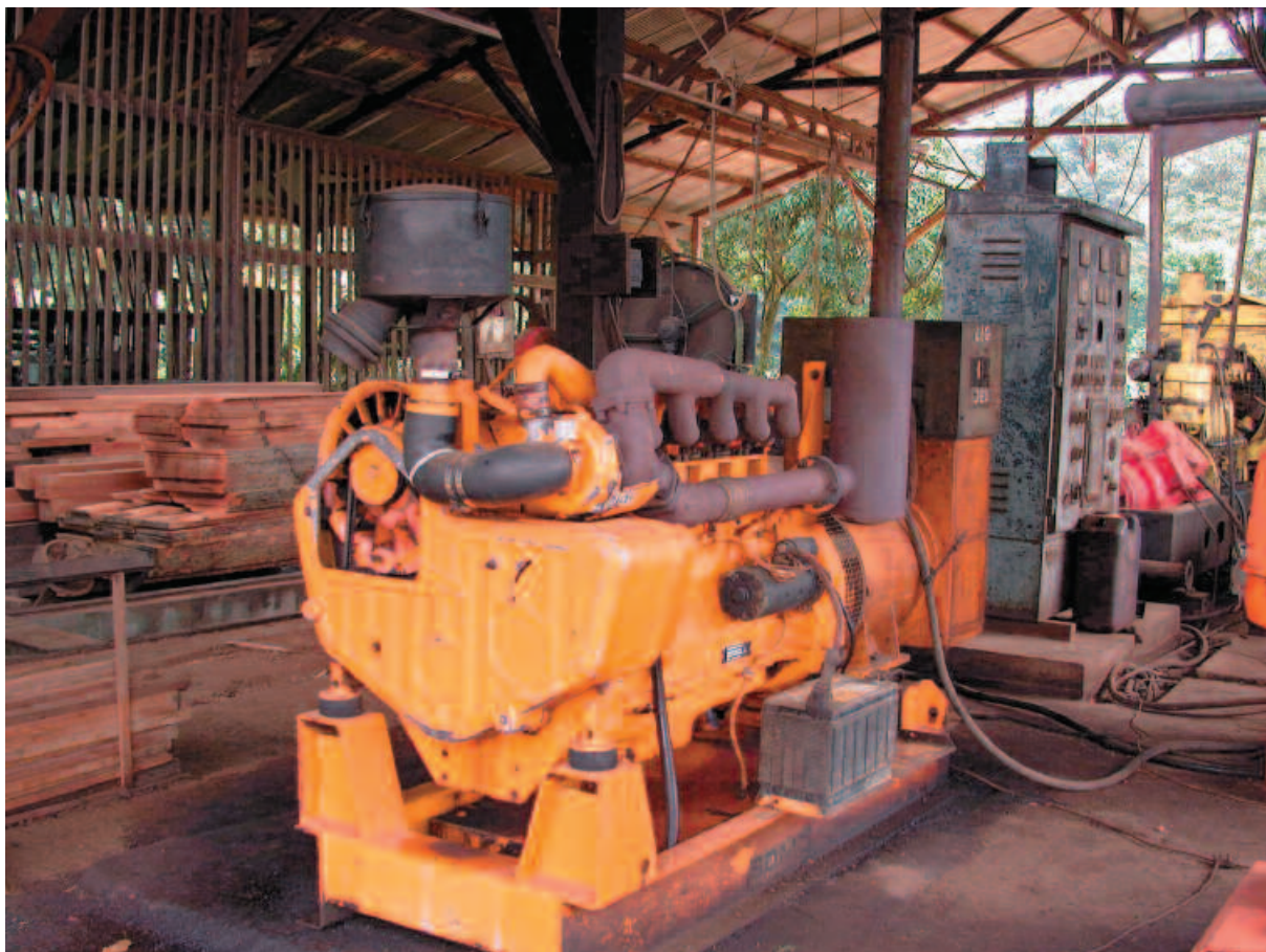
Groupe électrogène diesel en fonctionnement dans une scierie en Guyane. A diesel generator in a Guyanese sawmill. Photo F. Pinta.
