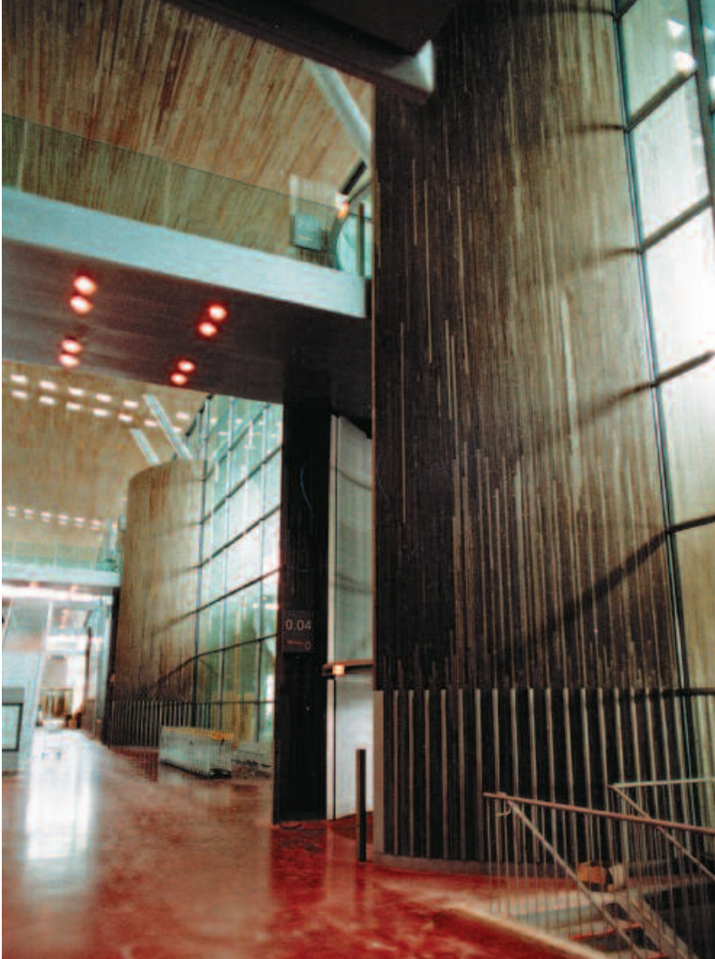
Habillage en bois des « fûts » dissimulant les portes d'entrée à tourniquet. Wood finishing on the casings masking the revolving entrance doors. Photo M. Vernay.
