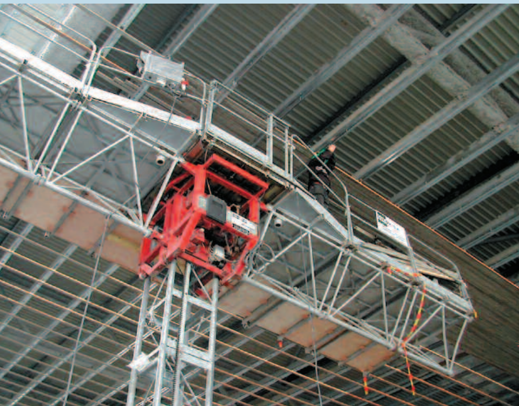
Exemple de nacelle avec plate-forme auto-élevatrice utilisée pour la mise en place des plafonds. Self-climbing work platform used to place the ceilings. Photo M. Vernay.
