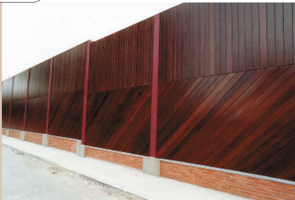
Écrans de 3,50 m de hauteur sur longrine béton et habillage en briques (vue côté riverains). Photo M. Vernay.
