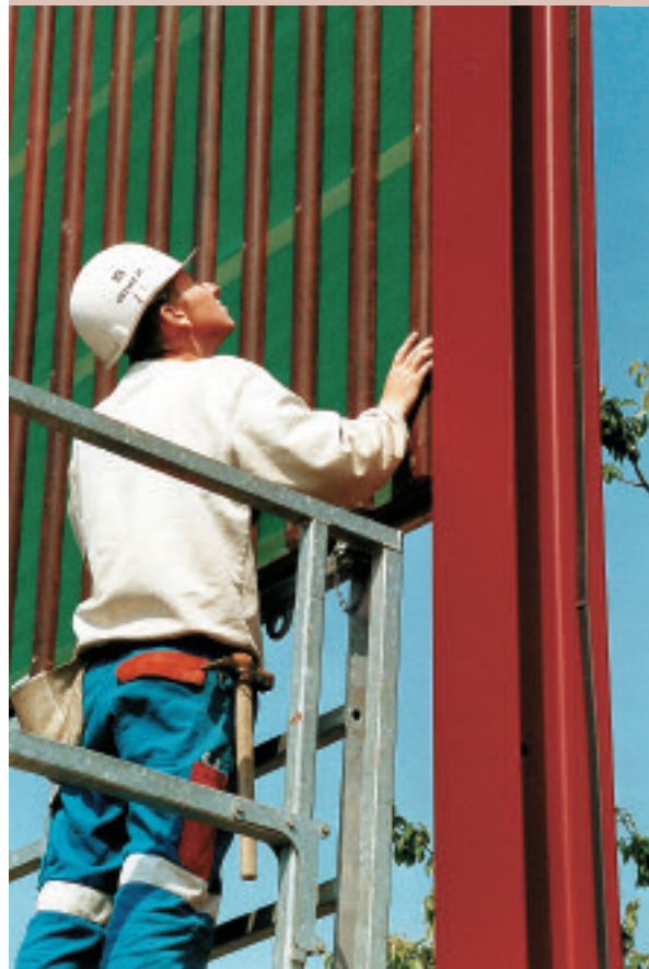
Mise en place d'un panneau par glissement à l'intérieur des poteaux métalliques. Photo M. Vernay.
