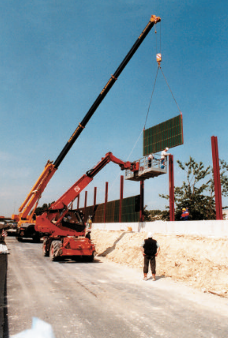
Pose d'un panneau acoustique à l'aide d'une grue. Photo M. Vernay.
