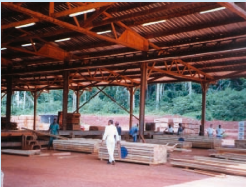
Plate-forme de mise en colis des avivés dans une scierie. Mindourou, Cameroun. A platform for packaging squared-off timber in a sawmill. Mindourou, Cameroon. Photo F. Pinta.
