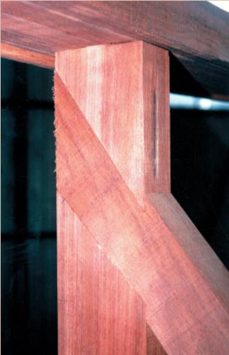
Assemblage d'une contrefiche sur un poteau par entaille à mi-bois et profil en queue-d'aronde.
