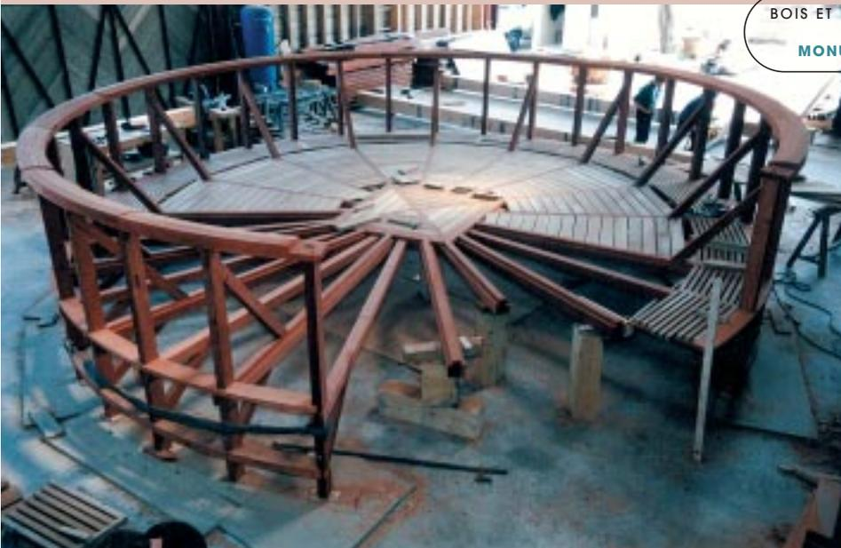
Pré-assemblage de la structure et du platelage de la terrasse de la tour ronde en atelier.
