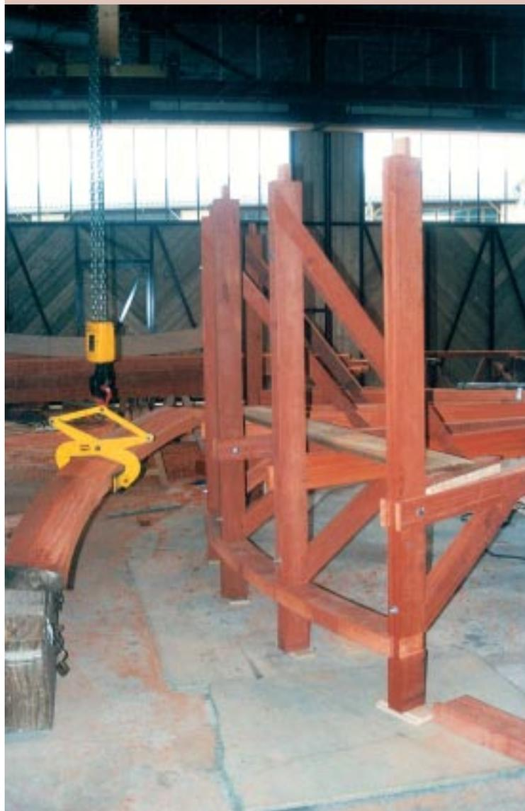
Pré-assemblage de la structure et du platelage de la terrasse de la tour ronde en atelier.
