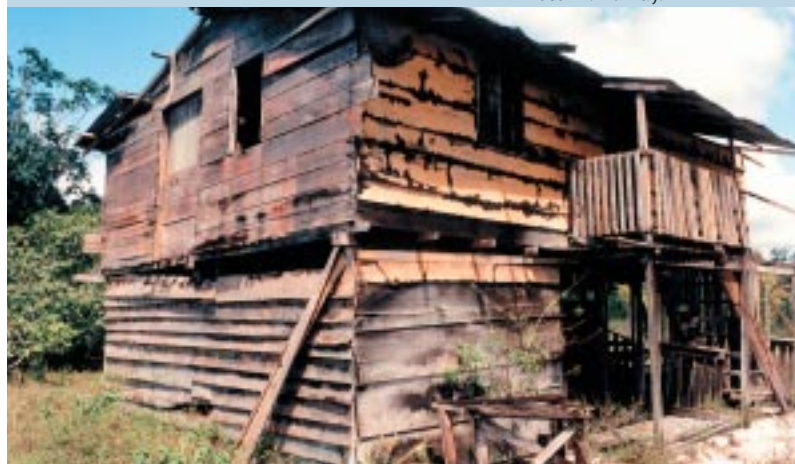
Photo 19. Maison détruite par les termites, en Guyane. House destroyed by termites, Guyana. Photo M. Vernay.
