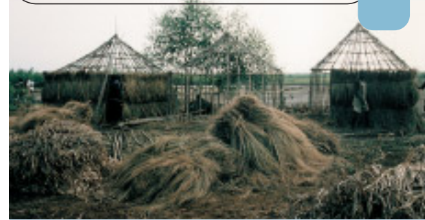
Utilisation du bois de palétuvier pour la construction des huttes sur les campements de production de sel.
