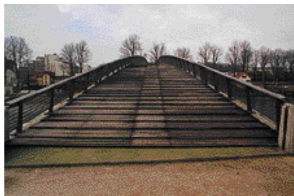
Photo 1. Platelage en ipé. Passerelle piétonne au-dessus du barrage de Saint-Maurice-Maisons-Alfort sur la Marne. Ipe decking. Footbridge above the Saint-Maurice-Maisons-Alfort dam on the river Marne.
