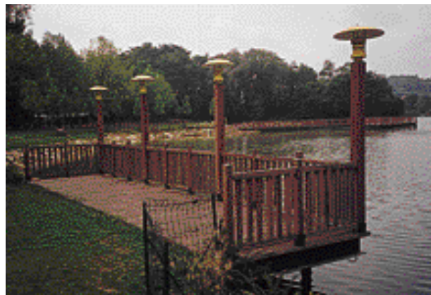
Photo 2. Ponton en azobé. Base de loisirs de Cergy-Pontoise. Pontoon made of azobe. Cergy-Pontoise leisure centre.
