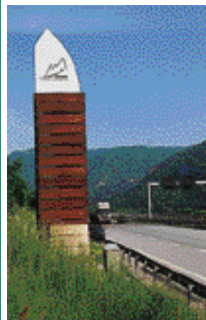
Photo 3. Signal en azobé. Autoroute et tunnel du Mont-Blanc (ATMB).
