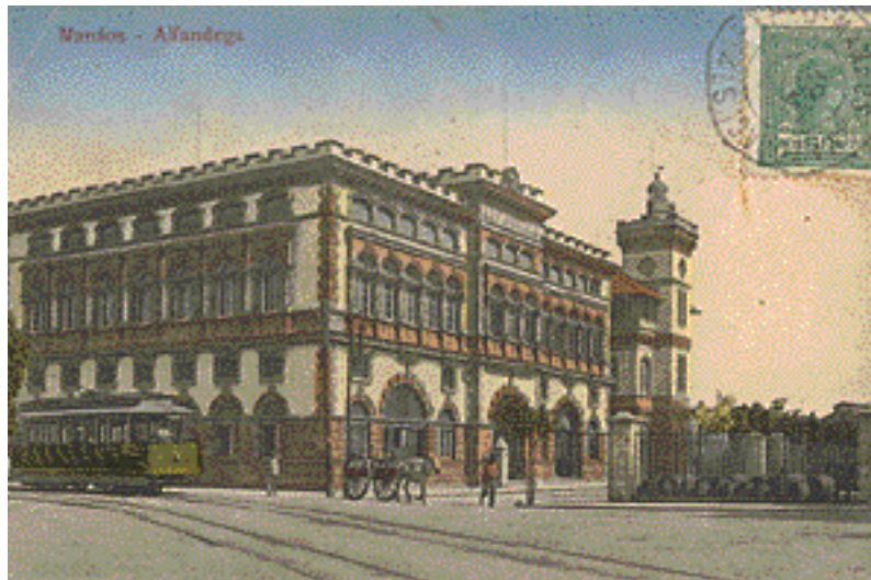
Photo6. L'immeuble des douanes a été construit en Angleterre, pour être démonté, transporté et enfin rebâti à Manaus.
