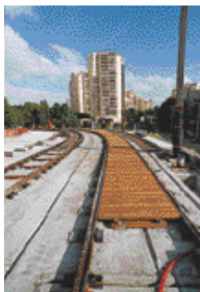
Photo 2. Pose entre les rails : détail des évacuations d'eau de ruissellement.
