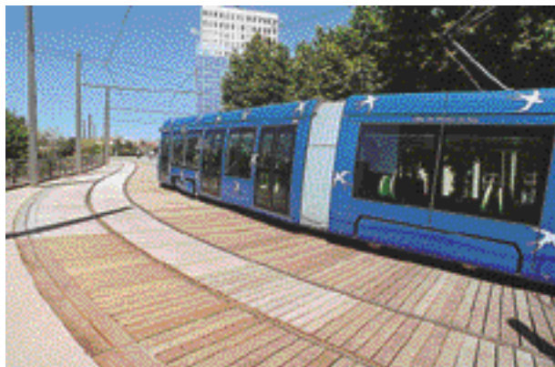
Photo 1. Vue générale du platelage en bois d'ipé ( Tabebuia sp.)
