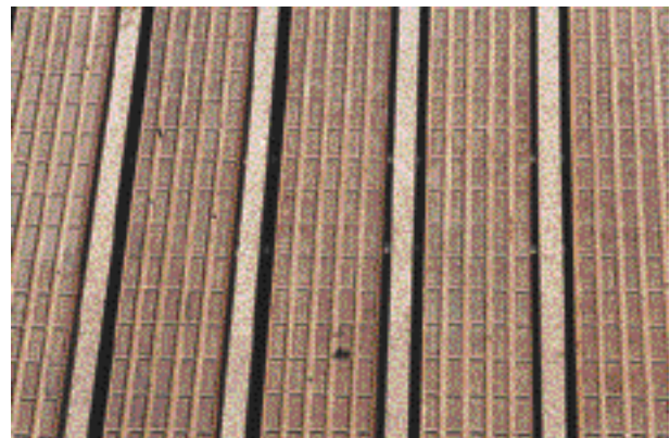
Photo 5. Détail de la conception du système antidérapant avec un double rainurage et une baguette de résine et corindon rapporté.
