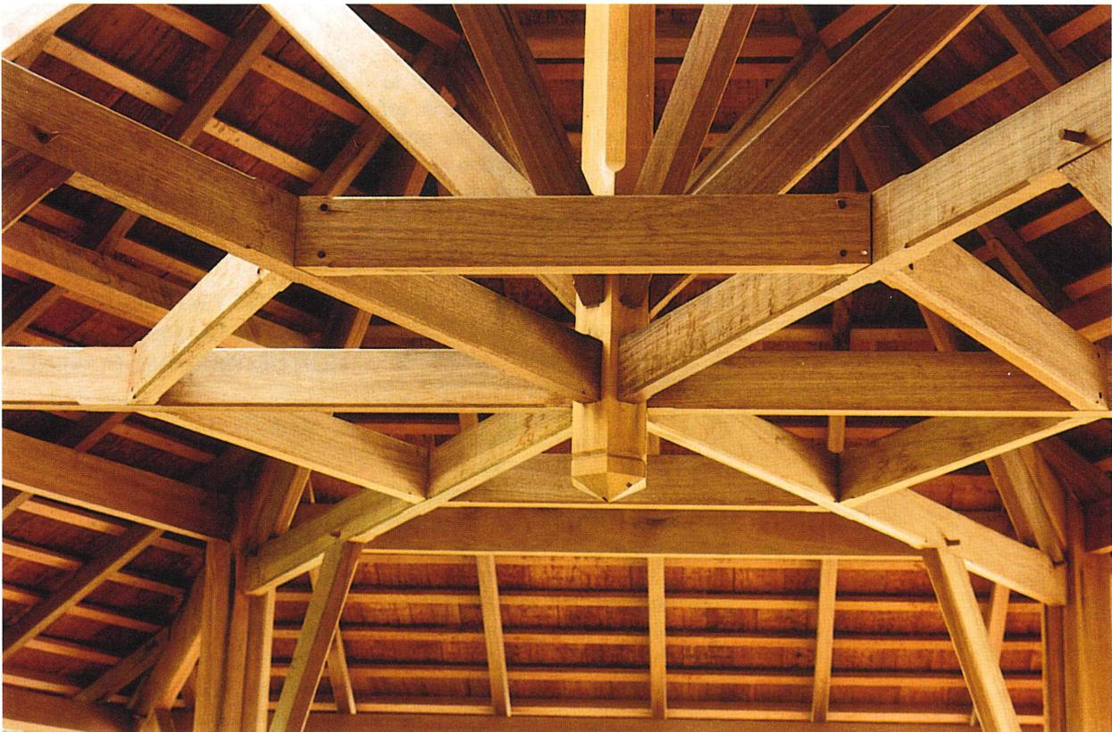
Charpente traditionnelle en bois de Guyane avec des pièces de structure soumises à différentes sollicitations mécaniques : fermes en Angélique, poinçons en Bagasse, chevrons en Gonfolo, couverture en Wapa.
