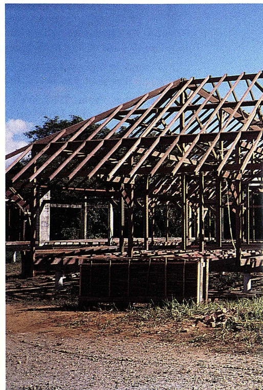
Construction à ossature bois. Locaux de l'ENGREF à Kourou charpente « GONFOLO ».
