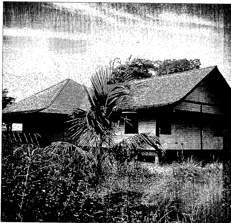
Villa entièrement en bois (couverture en bardeaux de WAPA).
