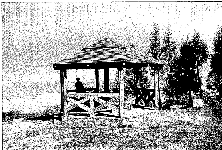
Un kiosque touristique, équipement très apprécié, peut-être parce qu'il s'apparente aux traditionnels « Guétali ».
